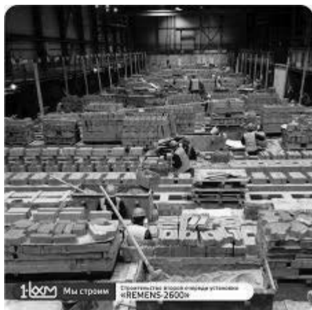
Рис. 2. Огнеупорная кладка коксовой батареи
